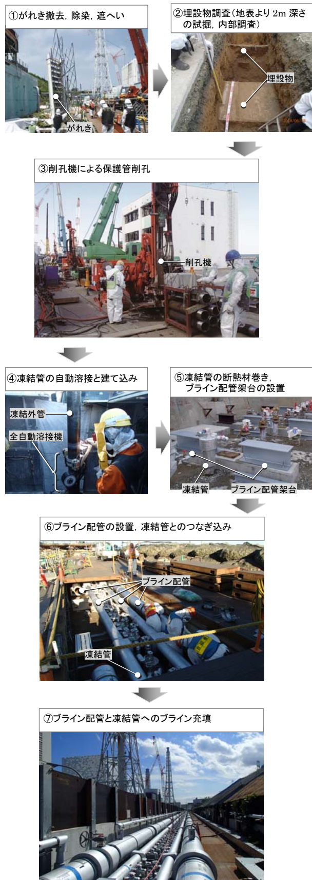
写真-1 凍結管とブライン配管の施工手順
