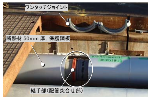
写真-4 配管継手部
