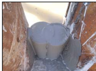
図4 鋼管矢板継手部(井筒形状)
