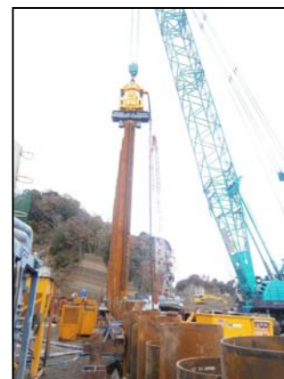
写真3 鋼管矢板打設
