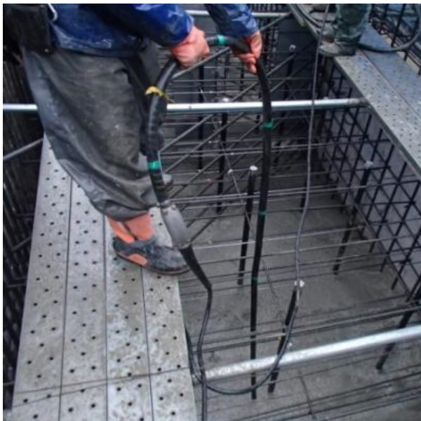
写真-2 バイブレータマーキング状況
