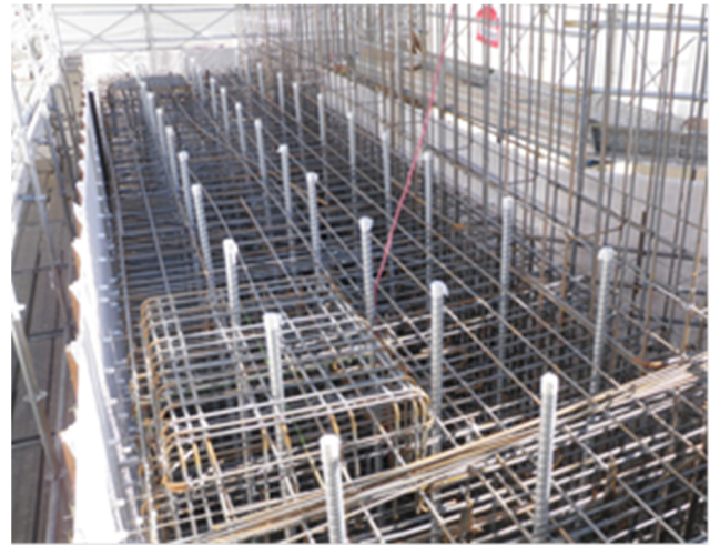
写真-6 クーリングパイプ設置状況
