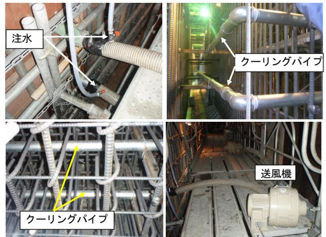
写真-3 クーリング機材設置状況
