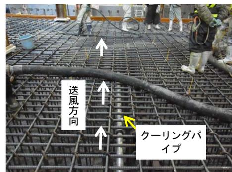
写真-2 底板打設状況
