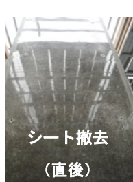
写真-5 シート撤去後の状況
