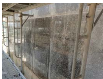
（シート撤去後）
