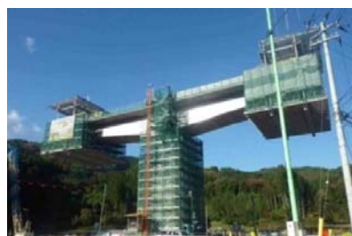
図-8 シート養生の対象範囲（上部工）
