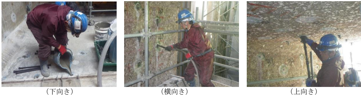
図-9 施工状況（グラウト注入・鉄筋挿入）
