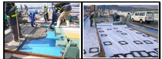
(c) 超速硬 SFRC 打込み (d) 封緘養生 写真-6 増厚補強施工状況
