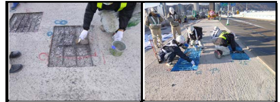
(c) 浸透性プライマー塗布 (d) 打継接着剤塗布
