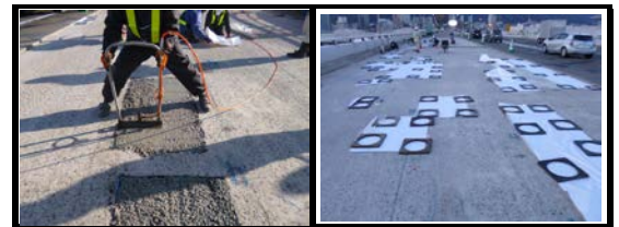
(e) 超速硬 SFRC 打込み (f) 封緘養生 写真-5 断面修復施工状況
