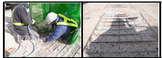
(a) 部分損傷のハツリ (b) ハツリ・清掃完了
