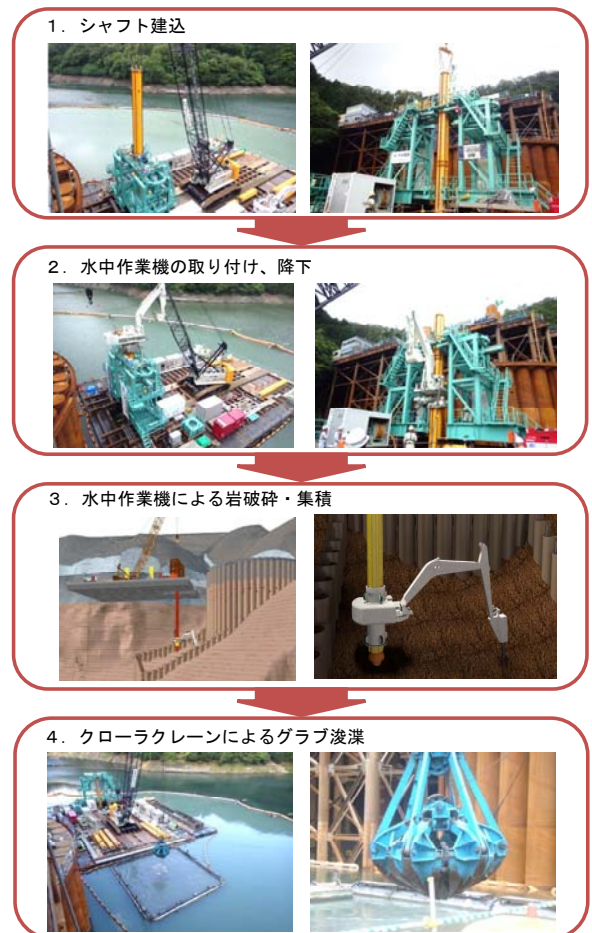
図-3 T-iROBO UW 施工フロー
