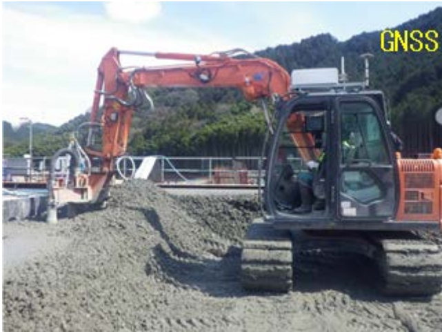
写真-1 バイブレータ締固め状況
