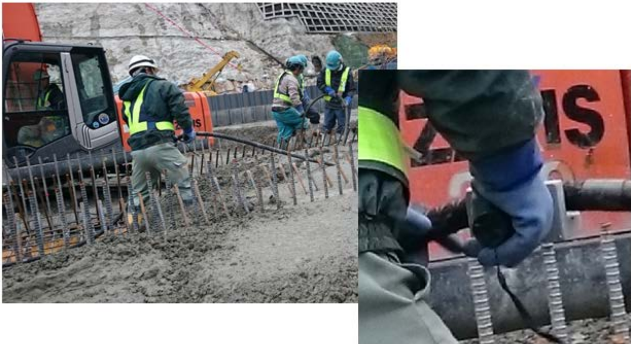
写真-5 現場での性能検証
