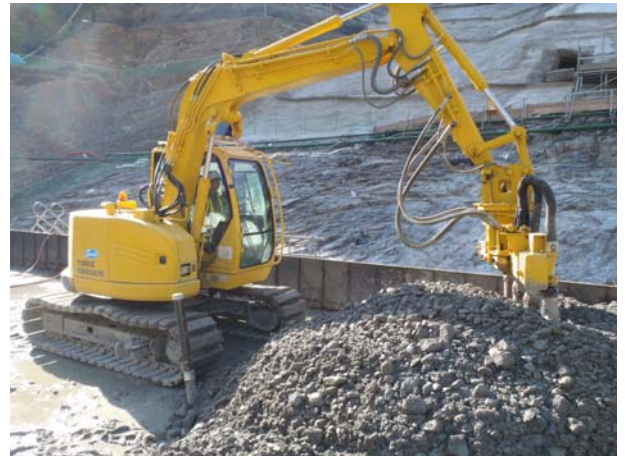
写真-1 山積み状態のダムコンクリート
