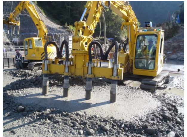
写真-6 実証実験での施工状況
