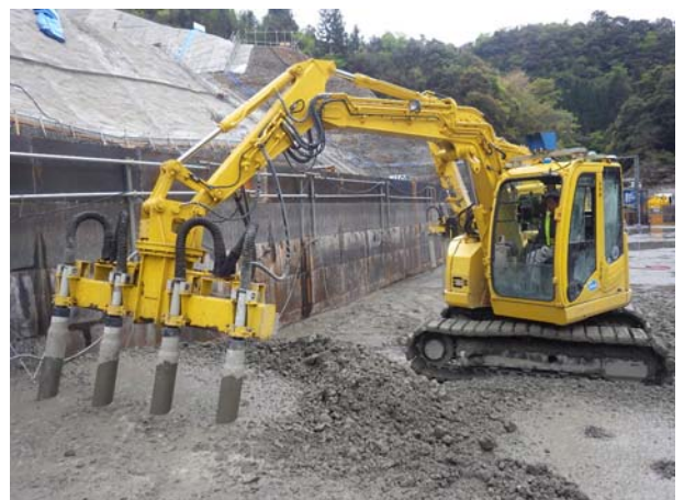
写真-2 締固め中のダムコンクリート
