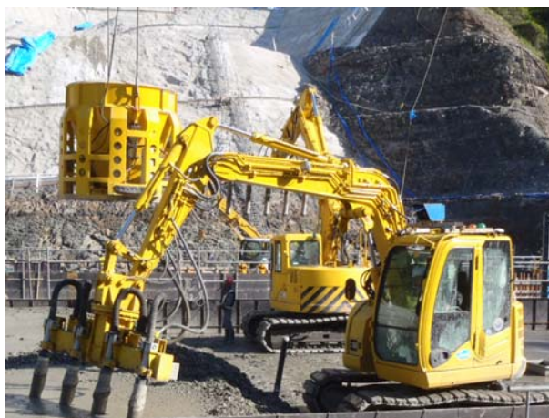
写真-7 コンクリート締固め状況
