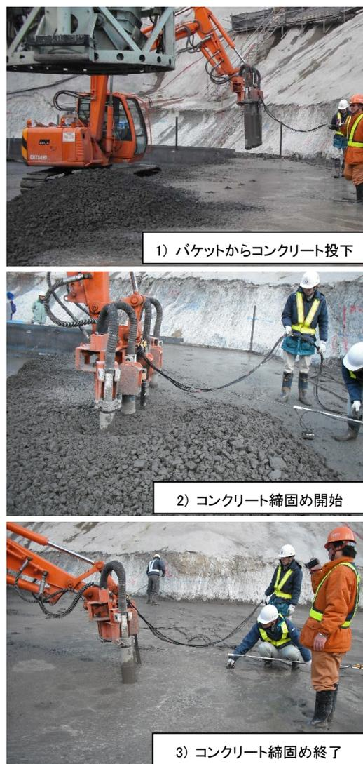
図-2 ダムコンクリートの締め固め状況変化
