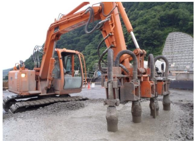
図-1 ダムコンクリート締固め状況
