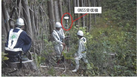
写真 4-4 GNSS+DC による測量状況
