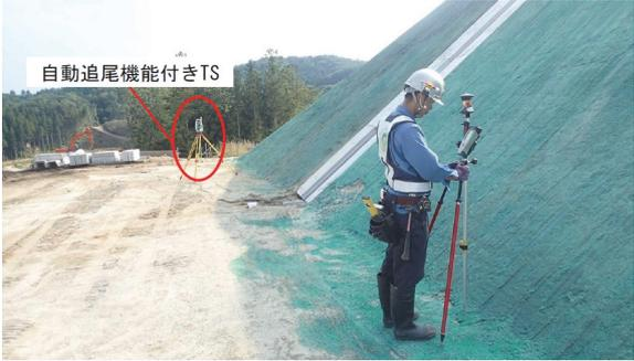
写真 4-3 TS+DC による測量状況
