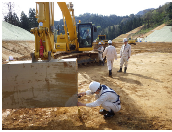
図-11 基準点オフセット補正値の確認
