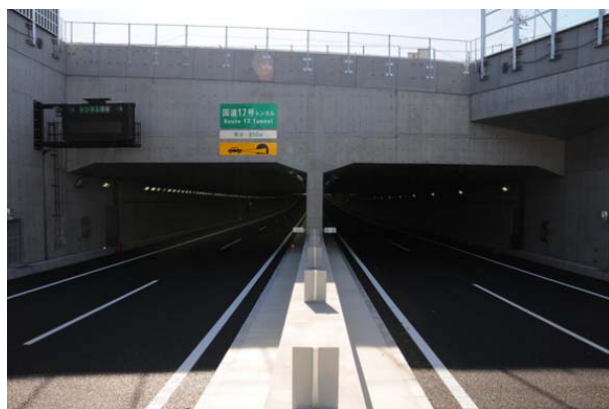
写真 5.1 開削部完成写真
