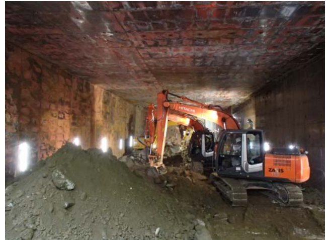
写真 3.4 内部掘削状況
