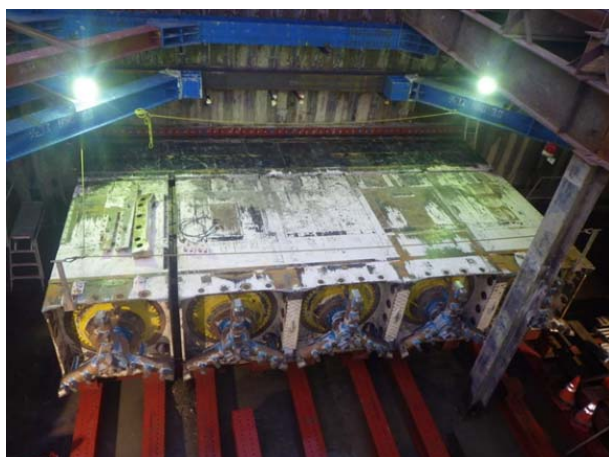
a) 横 5 連結推進機到達状況
