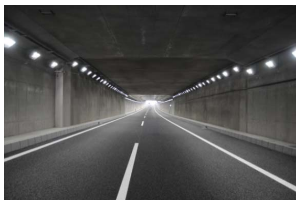
写真 5.2 非開削部完成写真
