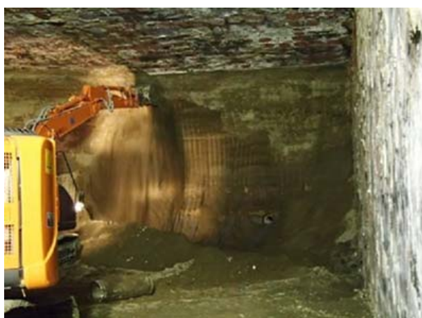
c) 外殻内部の掘削状況
