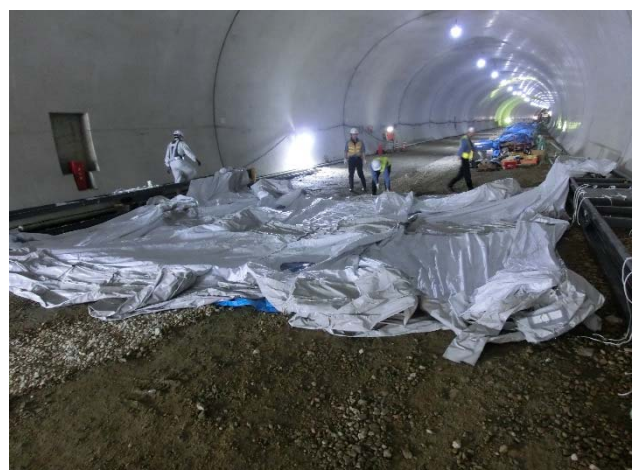
写真-3 エアフレーム敷き広げ
