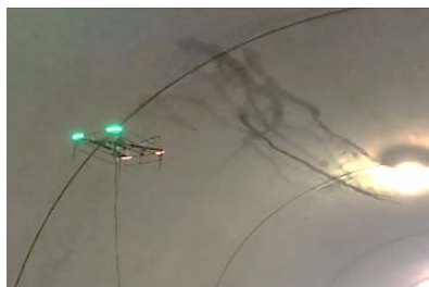
写真 6 天井方向吹付け状況
