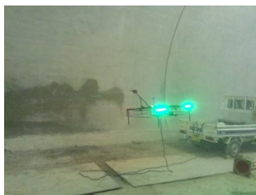
写真 4 壁方向吹付け状況
