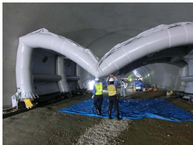
写真-4 空気注入状況
