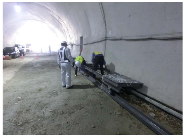
写真-2 レール・台車設置
