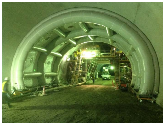
写真-5 設置完了
