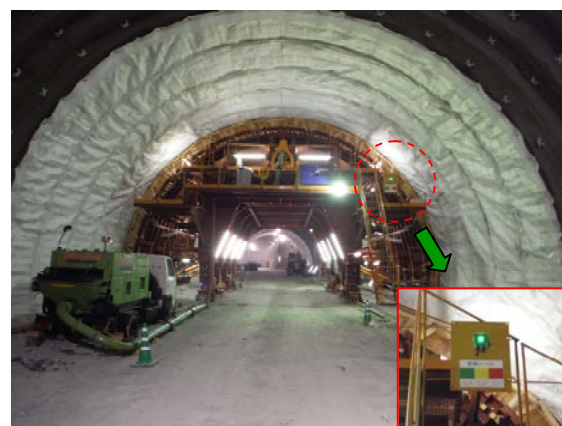
写真-13 FRP セントルと圧力管理の見える化
