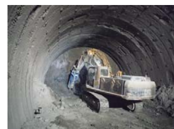
後進坑掘削状況（D I パターン）
