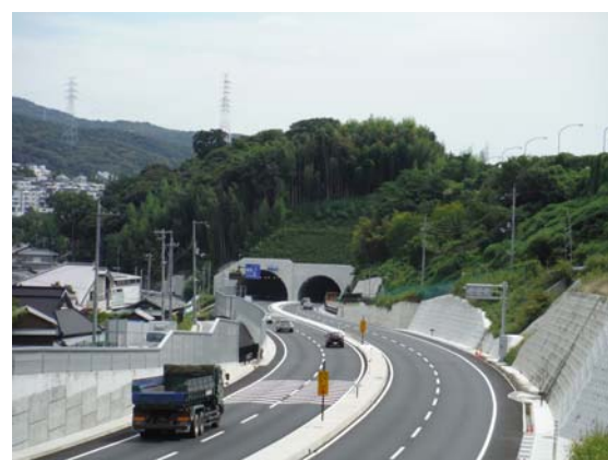
写真 14 トンネル供用状況 2)
