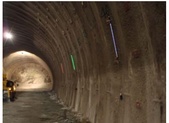
写真-8 干渉部監視状況（光る変位計） 2)
