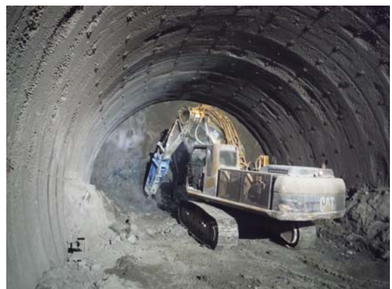
写真-10 上り線掘削状況（岩盤破砕剤+3.0t級併用）
