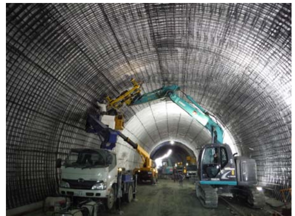
写真-11 ユニット鉄筋 現場組立状況
