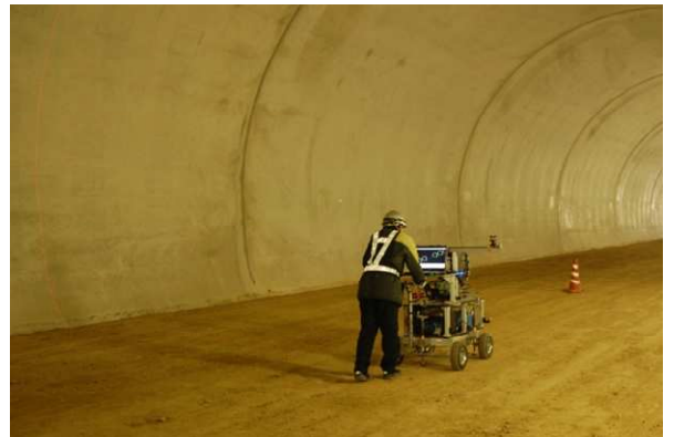
図 4 計測状況（三次元形状計測システム）
