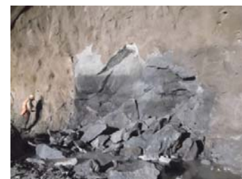
芯抜き状況（ガンサイザー使用）
