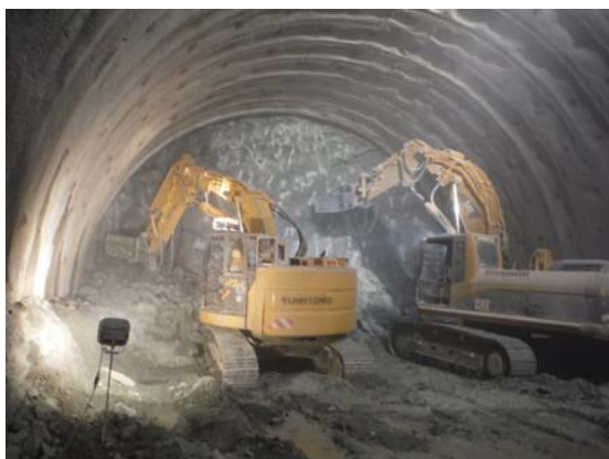
写真-9 下り線掘削状況（3.0t級+1.3t級併用）
