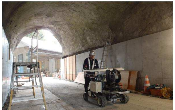
図 7 既設トンネル計測状況
