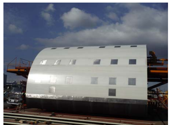
写真-12 FRP セントル 工場組立状況
