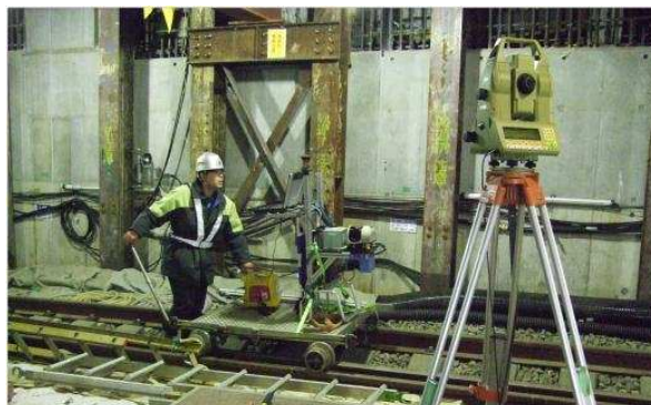
図 10 鉄道建築限界計測状況
