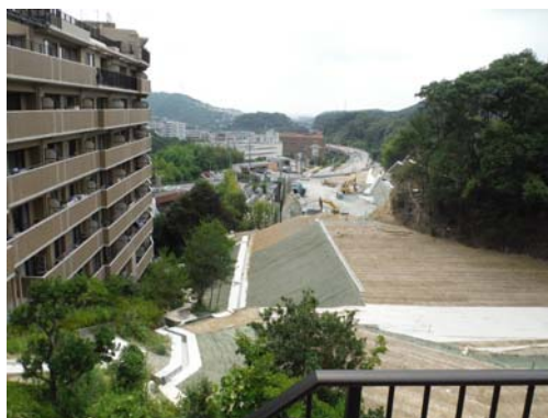
写真-5 終点側押え盛土施工状況
