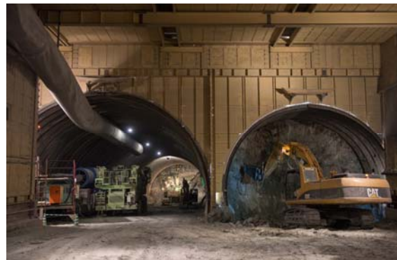
写真-1 トンネル施工状況
