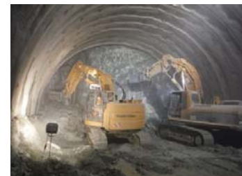
先進坑掘削状況（D I パターン）
