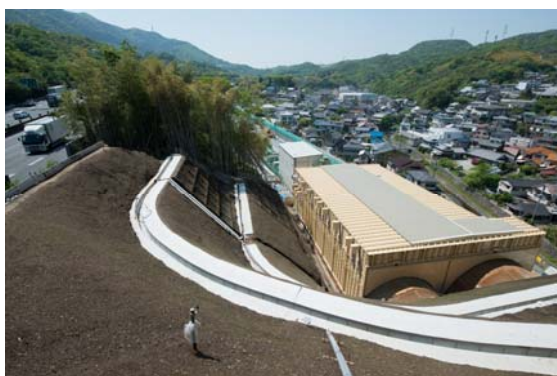
写真-4 起点側全景
