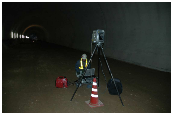
図 5 計測状況（市販レーザスキャナ）
