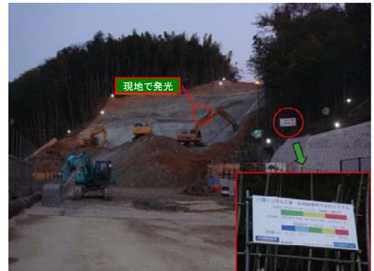
写真-7 起点側切土計測管理状況 2)
