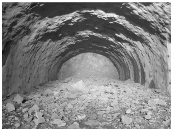
写真-13 発破後岩塊飛散状況(LP 雷管)
