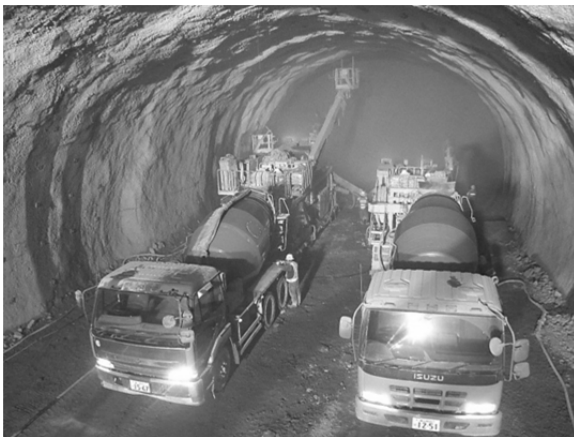
写真-4 吹付け時間短縮(2台吹付け)
