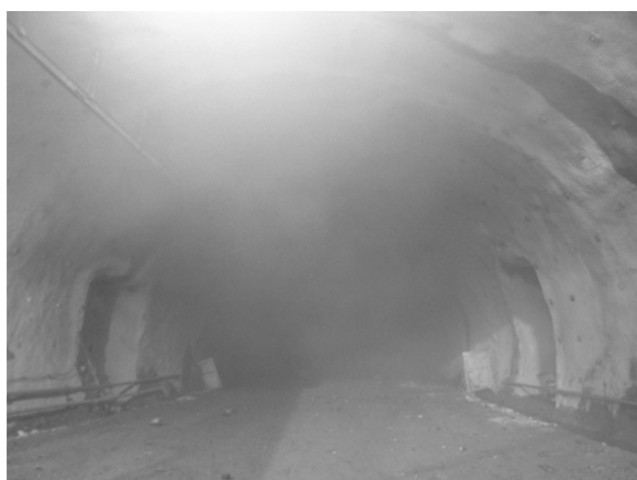
写真-11 発破後ガス封じ込め状況
