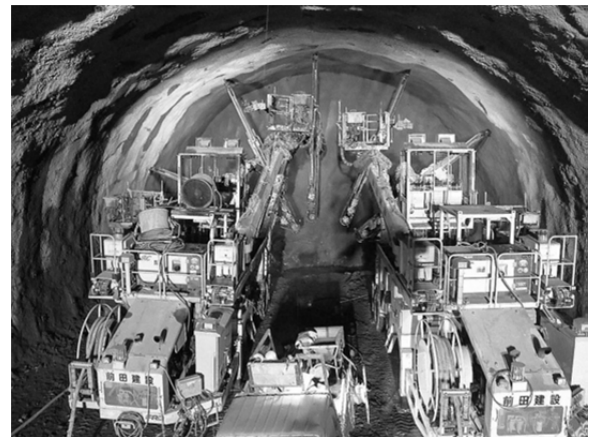
写真-5 ロックボルト時間短縮(2台施工)
