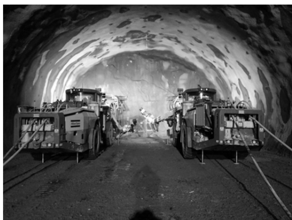
写真-9 釜石側工区ドリルジャンボ(全自動コンピュータジャンボ)
