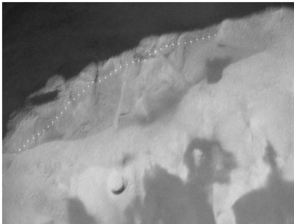
写真-6 自動追尾型レーザー断面照射
