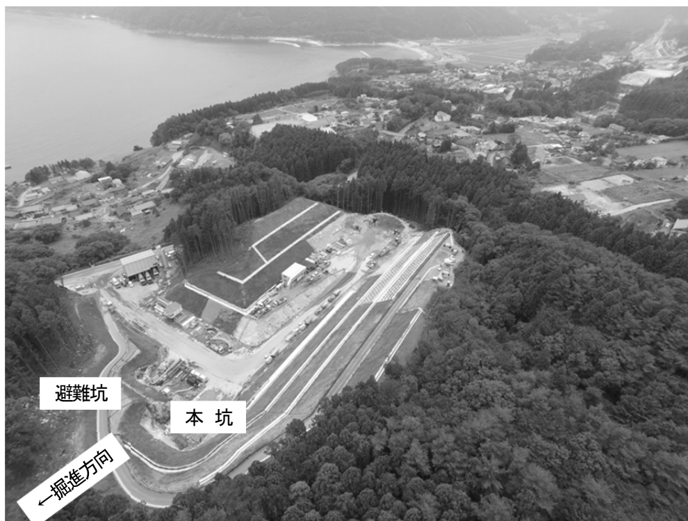
写真-1 坑口周辺環境(大船渡側坑口)
