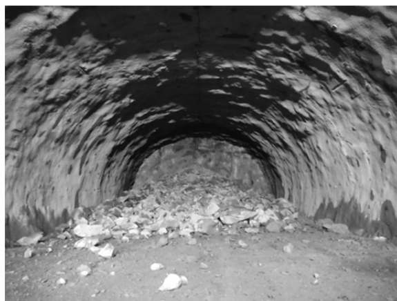
写真-14 発破後岩塊飛散状況(電子雷管 e-Dev II)
