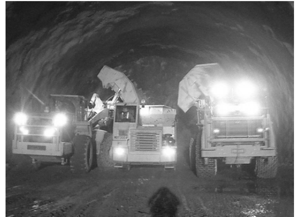
写真-3 高速ずり出し(2台積み込み)
