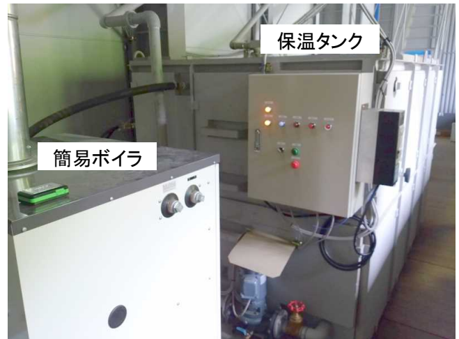
写真2 練混ぜ水用簡易ボイラと保温タンク
