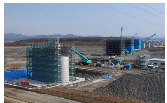
写真-4 揖斐川右岸下部工事施工状況
