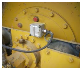
写真-4 加速度計設置状況
