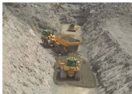
写真-3 敷均し・締固め作業状況
