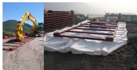
写真-8 コンクリート養生シート
