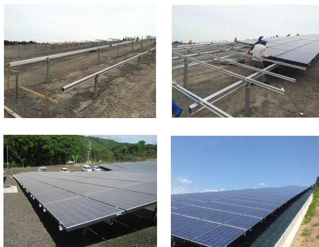
写真-4. アルミ製架台組立状況
