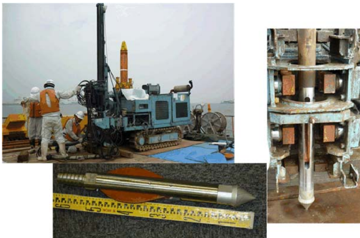
写真-1 現地計測状況
