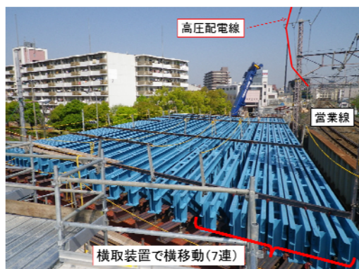
写真-8 トラス桁架設状況
