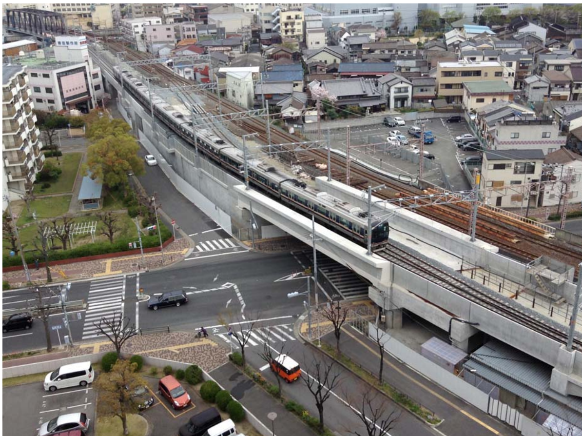
写真-1 鳴野都計第2架道橋供用状況
