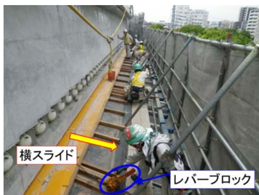
写真-10 底型枠解体状況
