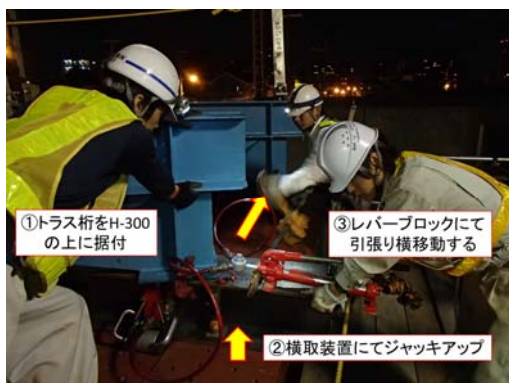
写真-6 横取装置による横移動状況（設置時）
