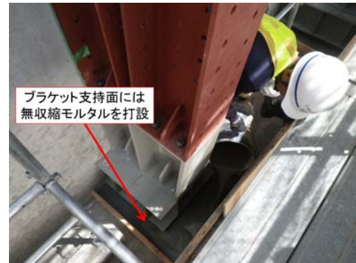
写真-4 ブラケット支承固定状況
