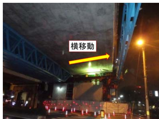
写真-9 トラス桁撤去状況
