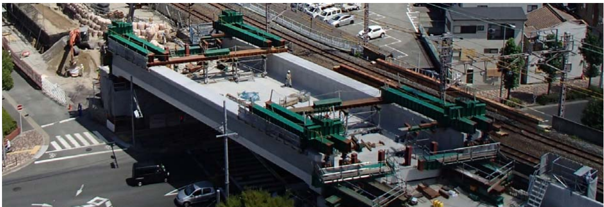
写真-14 ノーズ設備設置状況
