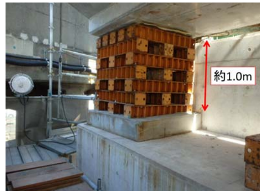
写真-13 ジャッキダウン完了
