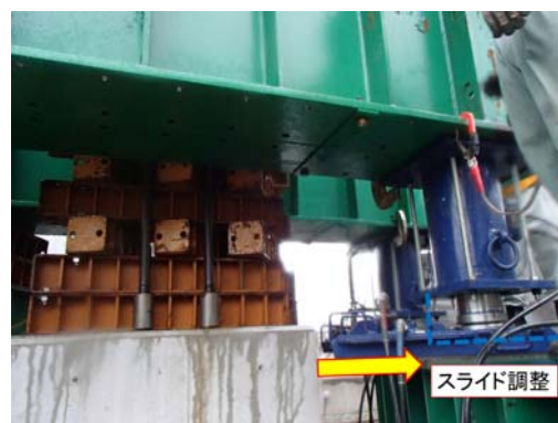
写真-19 水平位置調整状況
