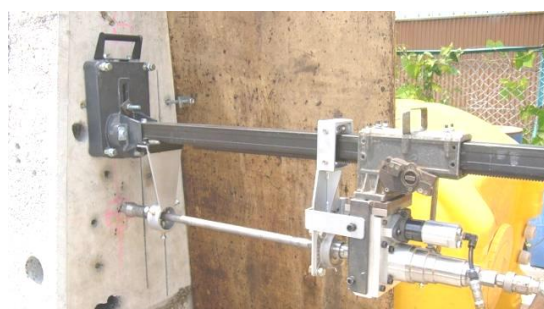
写真-4 WJ 削孔装置
