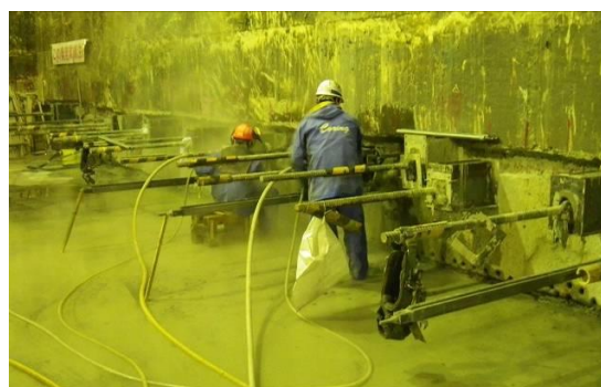
写真-5 削孔状況
