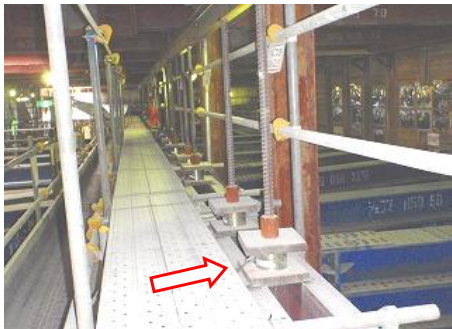
写真-2 センターホール荷重計（吊り鋼棒）
