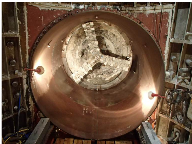
写真-6 シールド機と鋼管の接続完了
