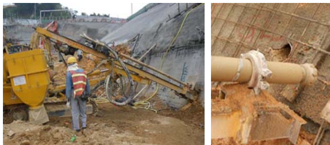
図-10 ソイルネイル施工状況(ケーシングなし)
