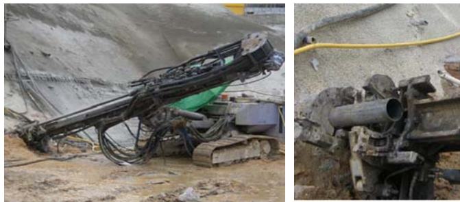
図-11 ソイルネイル施工状況(ケーシング併用)
