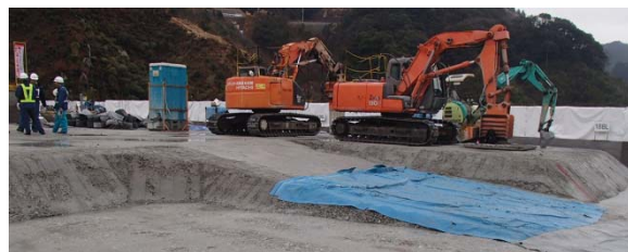
写真－ 11 RCD コンクリートの傾斜打止め状況
