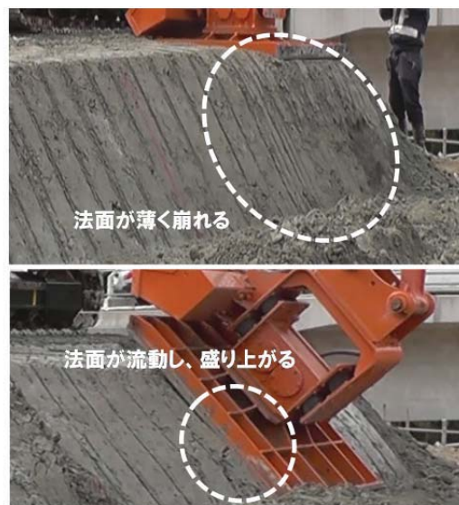
写真-9 端部締固め時の状況（VC 値 10 秒、法面勾配 1 : 0.8、締固め 15 秒）
