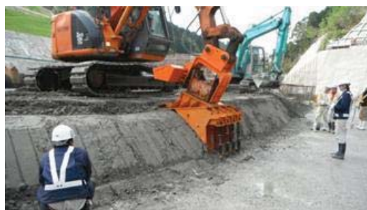
写真－7 二面拘束型専用機による締固め状況
