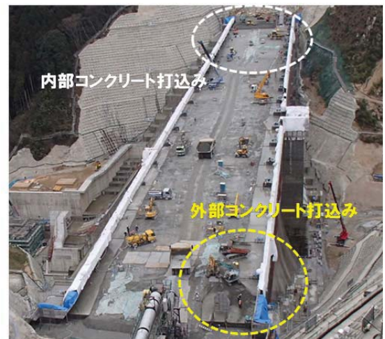
写真－4 コンクリート打込み状況
