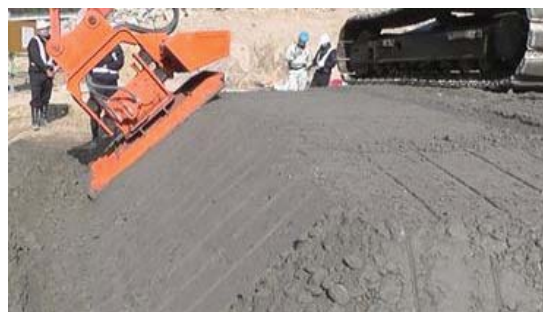
写真-10 端部締固め時の状況（VC 値 10 秒、法面勾配 1 : 1.0、締固め 15 秒）
