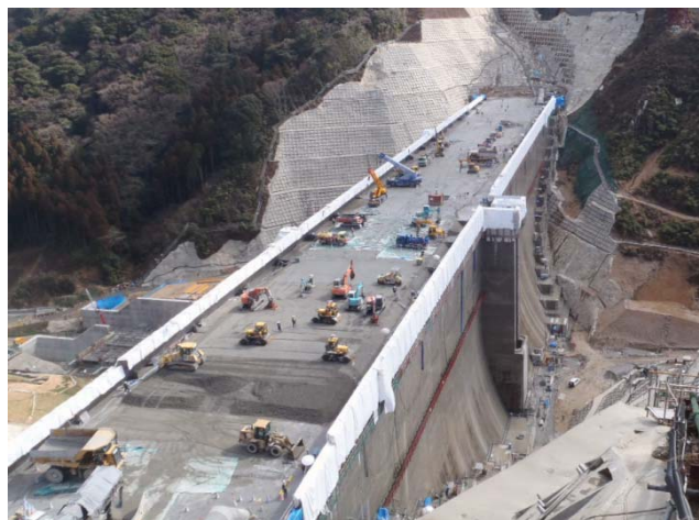
写真-1 五ヶ山ダム全景（2015年1月撮影）
