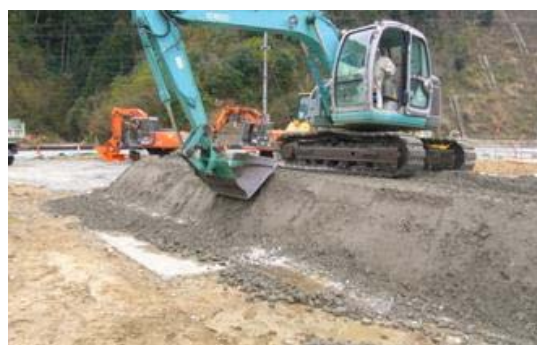
写真－6 端部法面の事前整形状況
