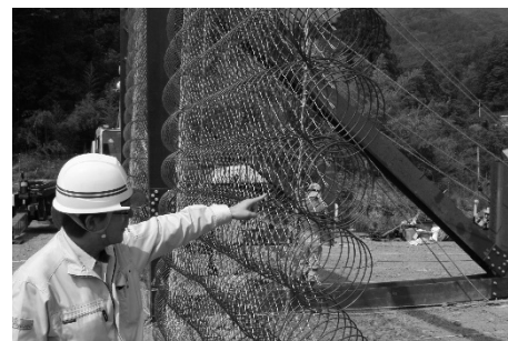
写真 3 コイルネット取付状況
