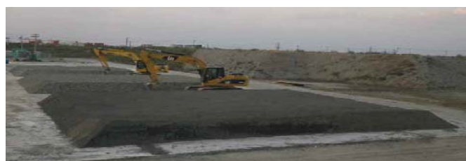
写真 4 脱水固化処理土の盛土造成状況
