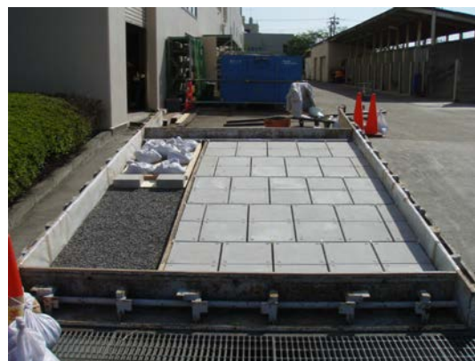
写真-5 急勾配箇所の試験施工
