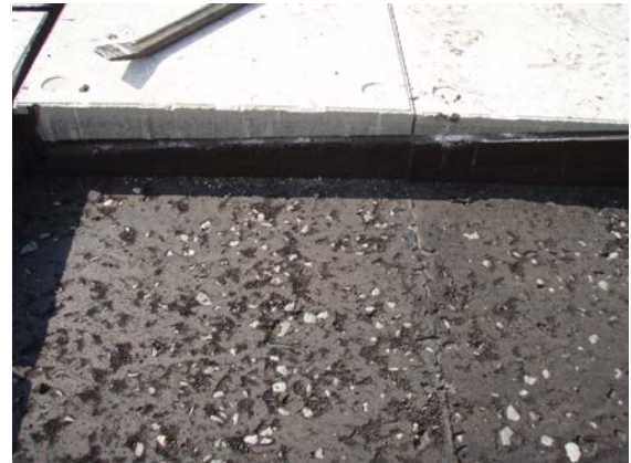
写真-7 CAE グラウトの充填状況
