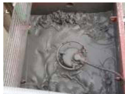
写真- 7 解泥状況
