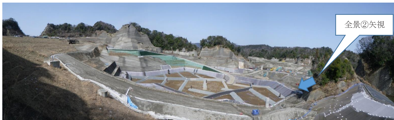
写真 5.1 完了写真 全景①
