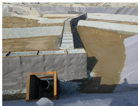
写真 3.1 碎石壁及び浸出水管設置状況
