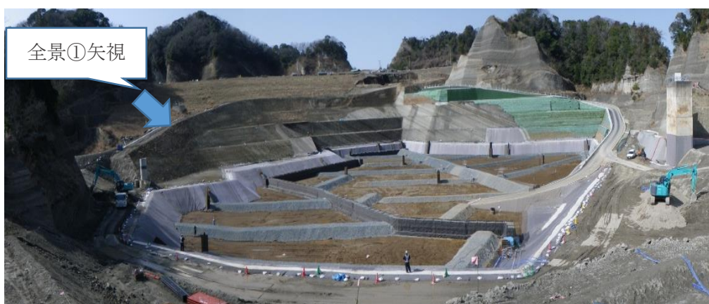
写真 5.2 完了写真 全景②
