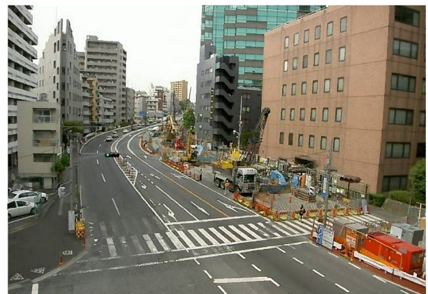
写真-1 地上部施工状況
