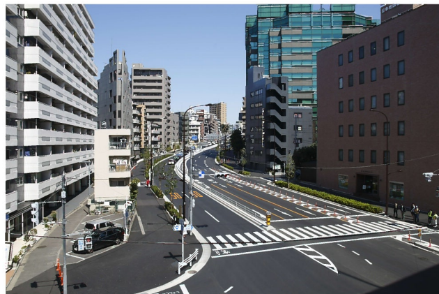
写真-9 地上部完成状況
