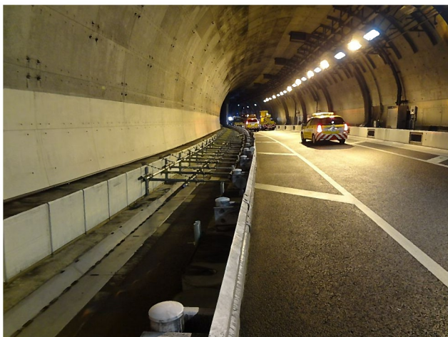
写真-6 供用中トンネル切開き「前」
