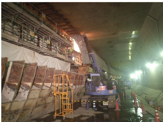
写真-2 セグメント撤去状況（工事側）
