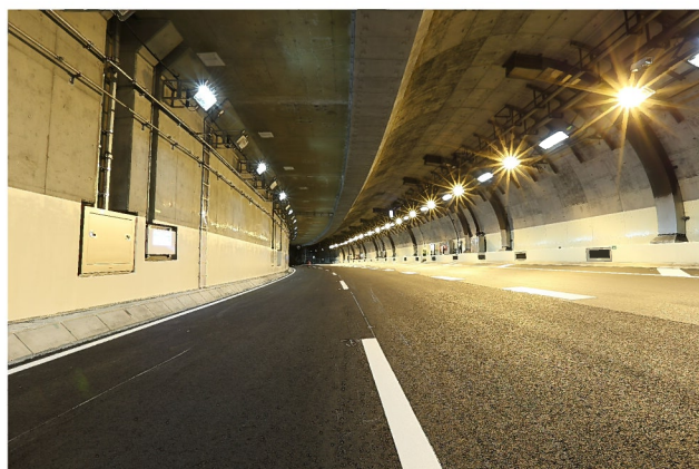
写真-8 品川線・新宿線接続部 完成状況
