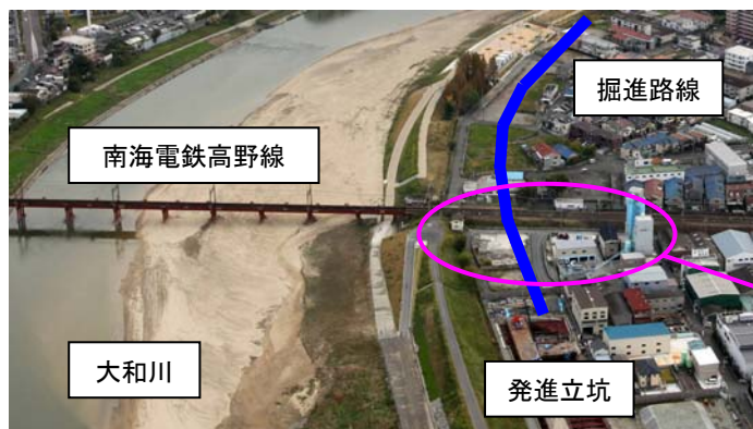
写真－4 初期掘進路線状況
