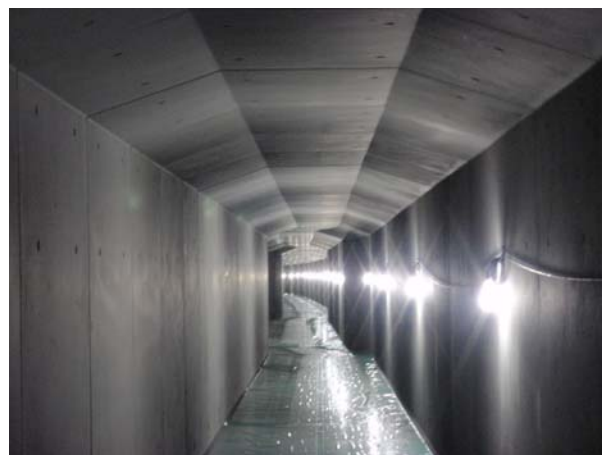
写真-6 避難通路ボックス設置完了状況
