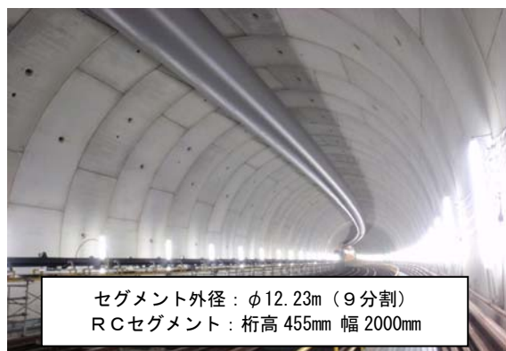
写真－２ RCセグメント区間
