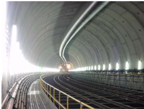
写真-5 一次覆工完了状況
