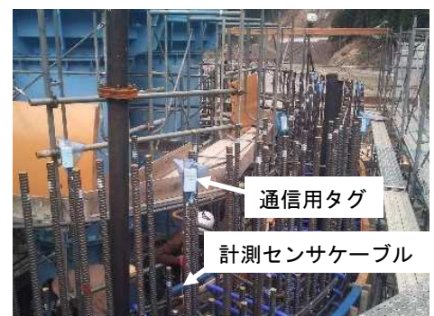
写真-6 計測機器の設置状況
