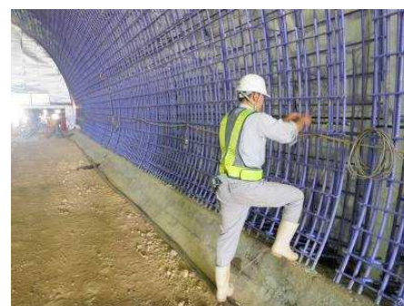
写真-8 センサケーブル設置状況(側壁部)
