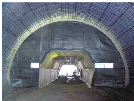
写真-16 大型モニタ設置状況
