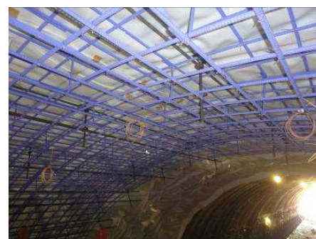
写真-10 センサケーブル設置(天端部 3 測線)
