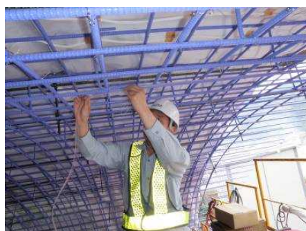
写真-9 センサケーブル設置状況(天端部)
