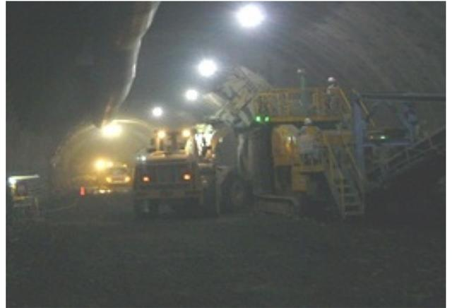
写真-4 ストックずり処理と切羽作業の同時作業
