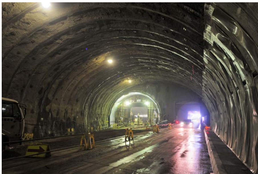
写真－3 分岐部施工状況(留萌側)
