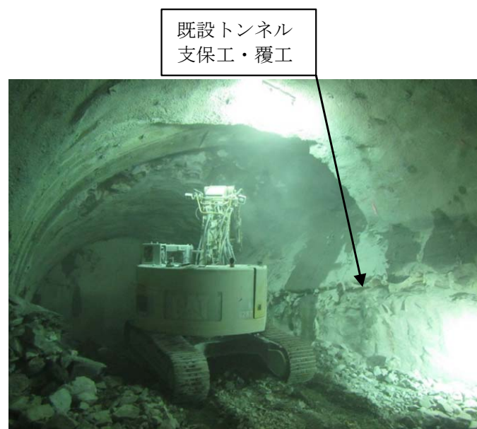
既設トンネル支保工・覆工を残しながら上半半断面を 12m 掘削
