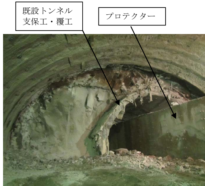
上記③④を繰り返し、12m 掘削完了した状況。
