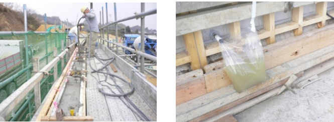
a. コンクリート施工状況 b. 余剰水の排出 写真-6 コンクリートの打込みと初期排水状況
