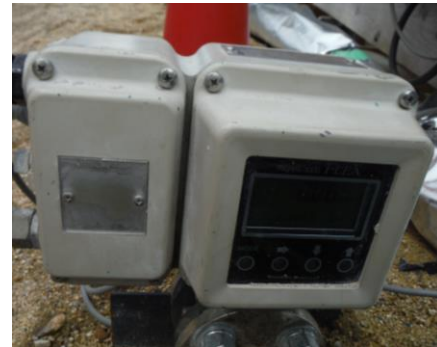
写真-3 1 インチ電磁流量計
