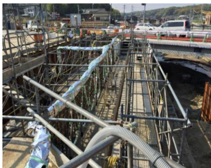
写真-1 パイプクーリング実施状況
