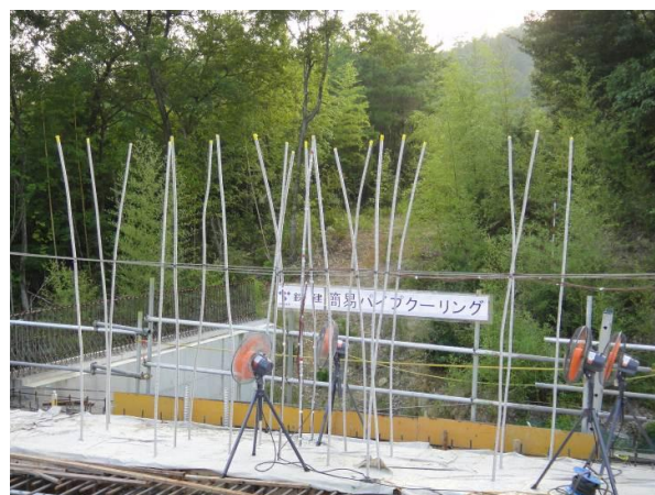
写真-2 ヒートパイプを利用したパイプクーリング状況
