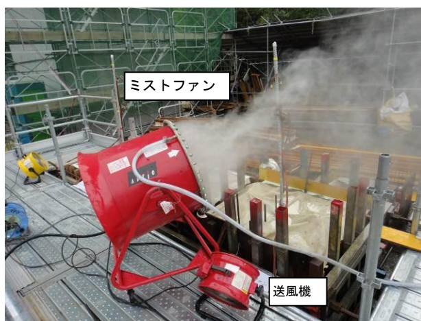
写真-1 ミストファンによる噴霧状況
