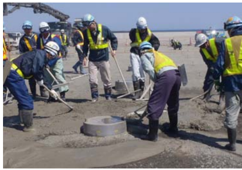
(b) 均しコンクリート打設
