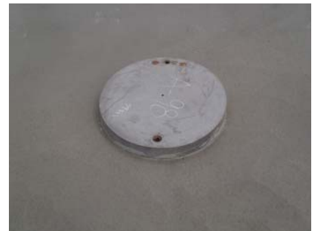
(c) ボルト撤去
