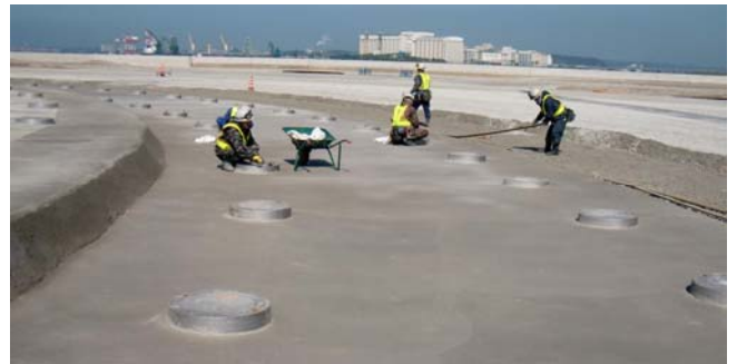
写真 2 FT キャップ設置状況
