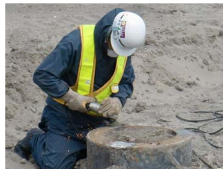
(b) 杭頭部平滑作業状況
