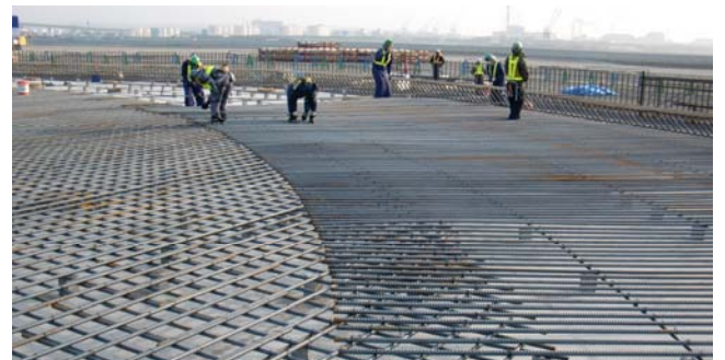
写真 3 下筋配筋状況
