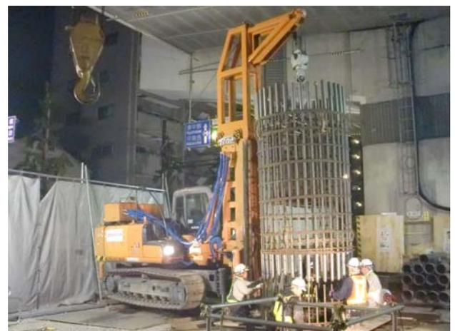
写真-1 場所打ち杭鉄筋かご建込み状況
