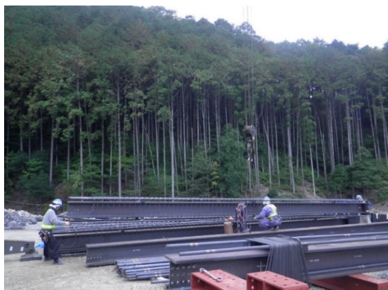
写真-3 ユニット鋼材の地組み
