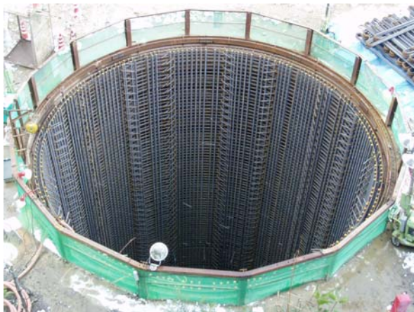
写真－1 大口径深礎基礎の配筋状況
