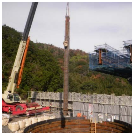
写真-4 ユニット鋼材の建込み(1)
