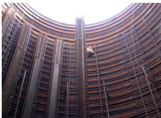
写真-5 ユニット鋼材の建込み(2)
