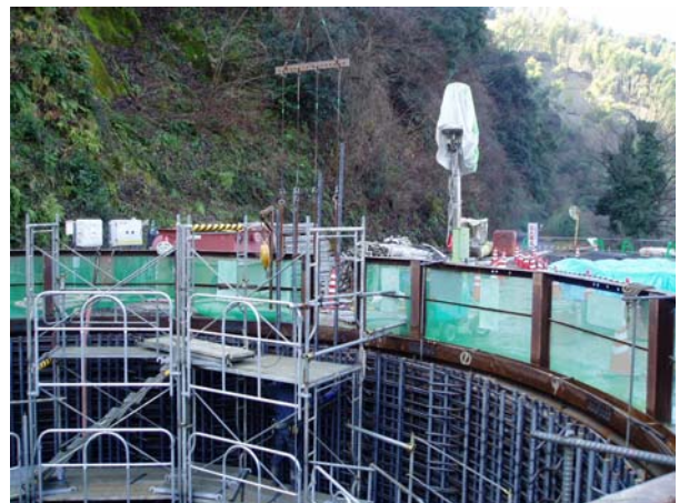
写真－2 軸方向鉄筋の吊り込み状況
