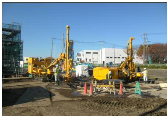
写真－7 削孔状況（PD19 橋脚）
