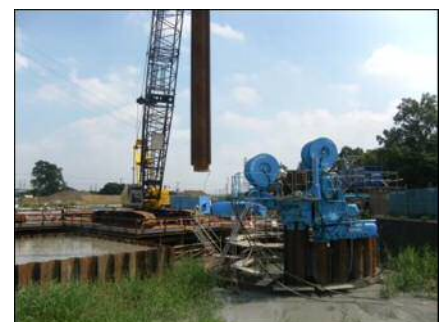
写真－３ 鋼管矢板施工状況
