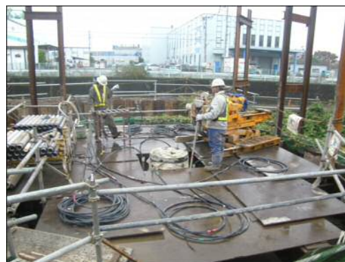
写真－8 注入状況（PU20 橋脚）
