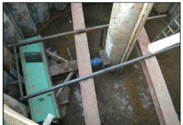
写真－4 水平載荷試験装置
