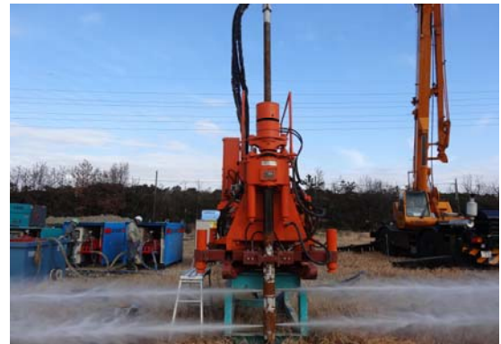
写真－2 多孔管式特殊モニター
