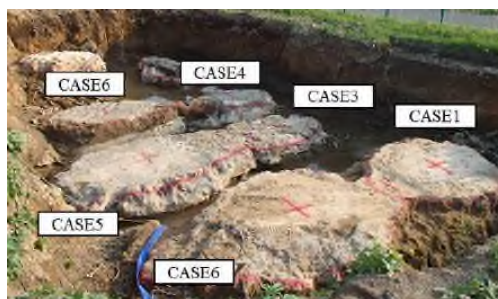
写真1 コラムの掘起し状況
