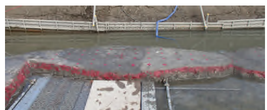
図 14 掘起したコラムの出来形状況（千葉県浦安市）
