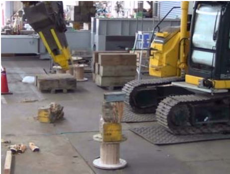
写真—6 ドラムに角材等を積上げる作業
