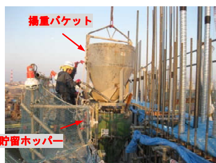
写真-1. コンクリート打設状況
