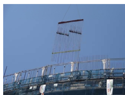
写真-3. 鉛直鉄筋組立状況
