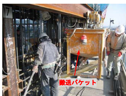
写真-1. コンクリート打設状況
