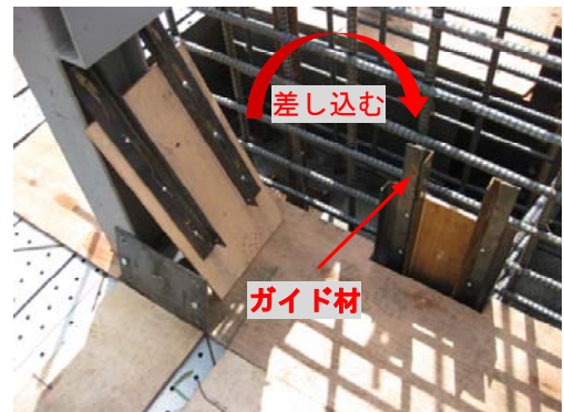
写真-4. 置き型枠
