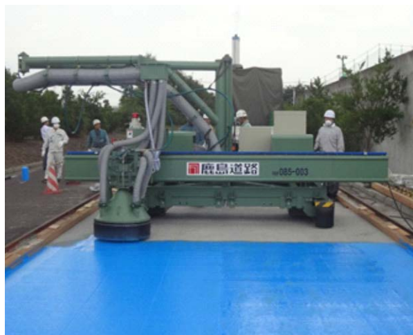
写真-4 試験施工における塗布状況
