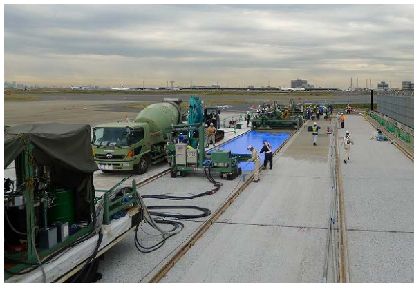
写真-6 大規模補修工事における施工状況
