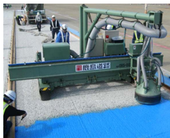
写真-5 大規模補修工事における塗布状況
