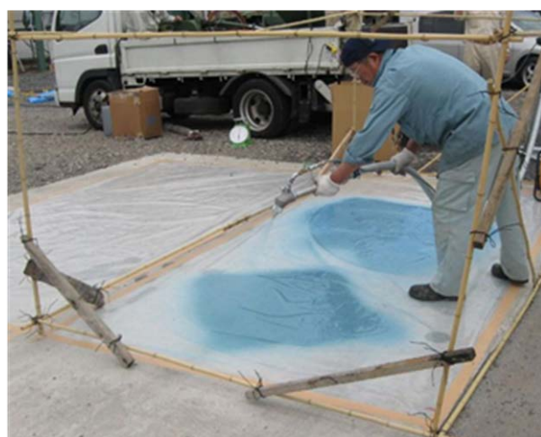
写真-3 ノズル選定検証状況
