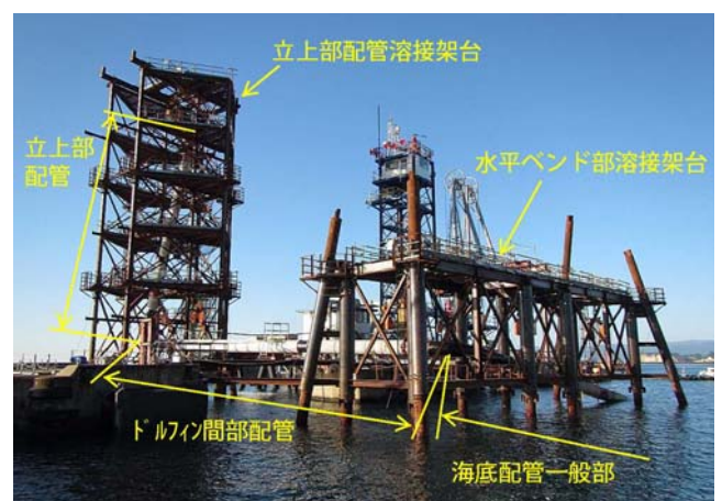
写真-8 シーバース側立上部配管施工状況全景
