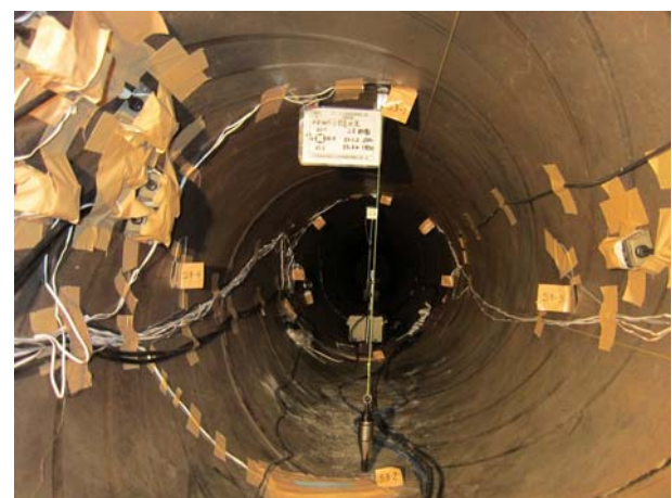
写真-3 ひずみ計設置状況
