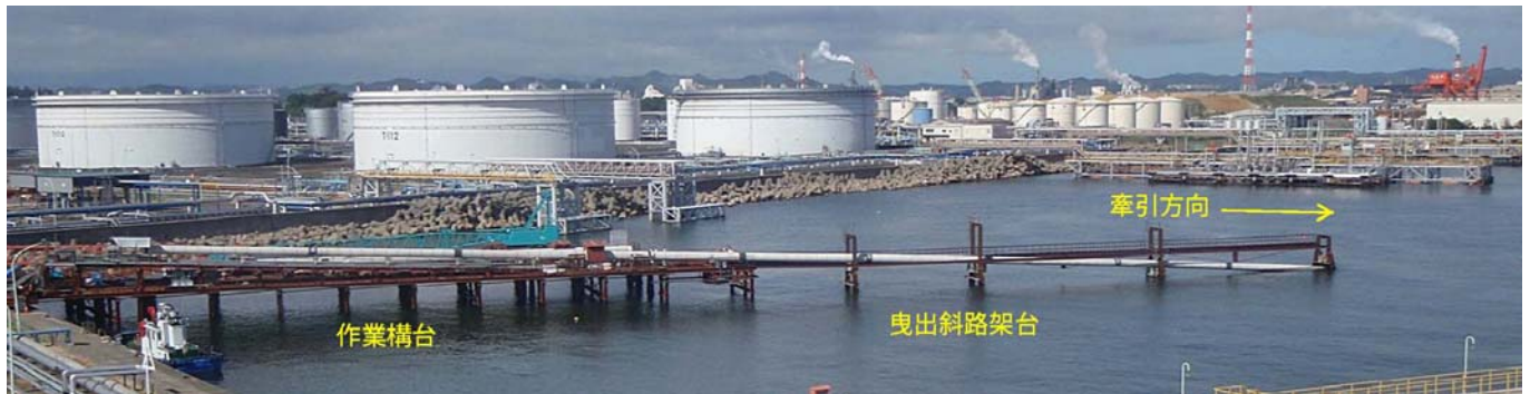
写真-4 曳航作業状況（陸側作業構台）
