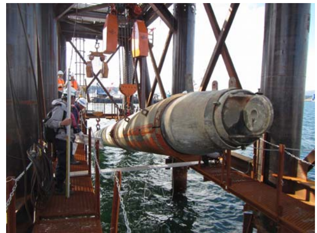
写真-6 海底配管先頭部吊上げ状況
