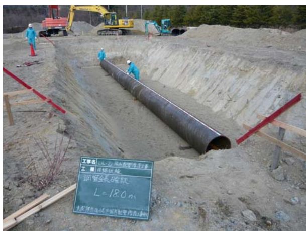
写真-2 鋼管設置状況
