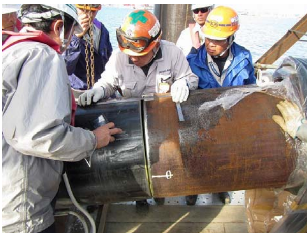
写真-7 配管開先合わせ作業状況
